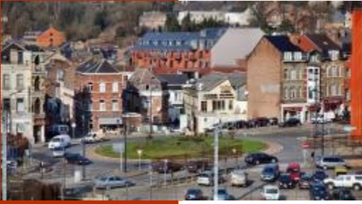
L'ensemble des bâtiments des « Trois Portes » est situé dans les quartiers de Bomel et d'Herbatte, derrière la gare de Namur.
